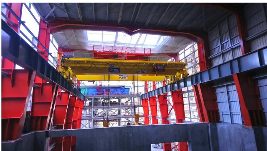
Au fort tonnage s'est ajoutée une difficulté supplémentaire : l'appareil a dû, compte tenu de ses caractéristiques hors normes, être fabriqué suivant les spécifications EDF extrêmement contraignantes RRCMH (Règles de Réalisation et de Contrôle des Matériels Hydrauliques), habituellement appliquées aux conduites forcées et aux vannes.
